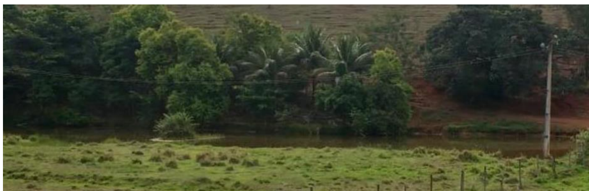
FIGURA 4. Situação da lagoa onde é depositado o volume excedente de água pluvial. Fonte: Os Autores (2019).
