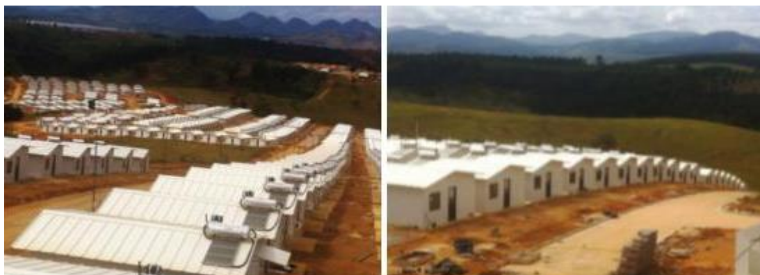
Figura 2 – Habitações em Sistema Concreto-PVC localizadas no Loteamento Nilson Soella III - Colatina (ES)
