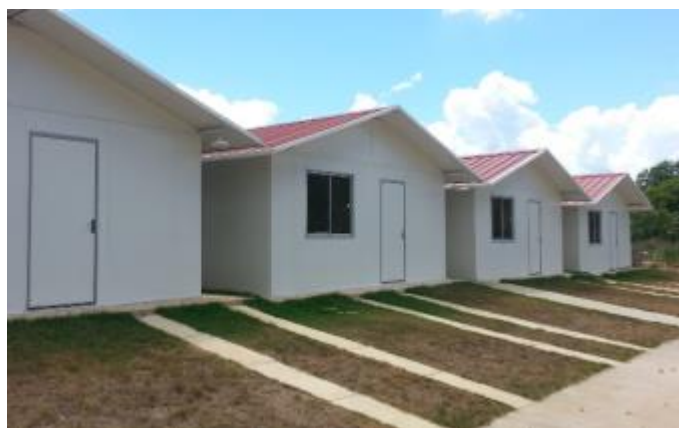
Figura 5 – Habitações modulares edificadas pelo método construtivo Mobile Steel System localizadas no Bairro Barbados - Colatina (ES)
