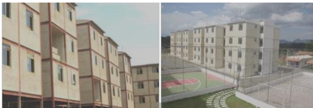
Figura 7 – Habitações em Sistema Integrado de Estrutura Metálica localizadas no Residencial Esperança – Cachoeiro de Itapemirim (ES)
