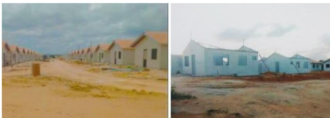
Figura 3 – Habitações em Sistema Concreto-PVC localizadas no Conjunto Residencial Jocafe - Linhares (ES)
