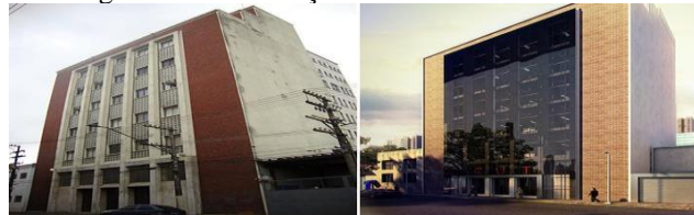
Figura 1. Revitalização de Fachada com Retrofit
