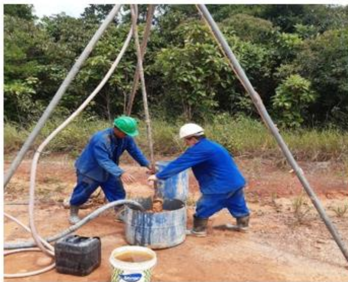
Figura 2 – Sondagem em execução (Autor, 2021)
