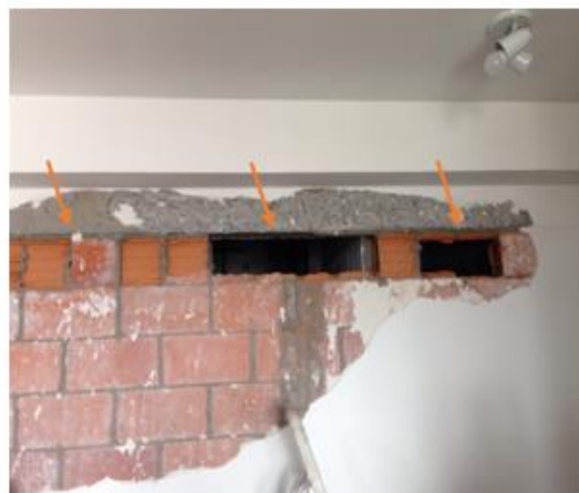
Figura 02: Patologia ocasionado na região do encunhamento na parte interna de edifício
