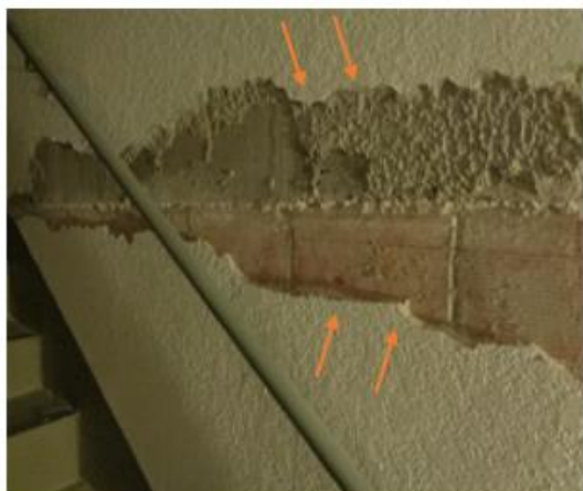
Figura 02: Patologia ocasionado na região do encunhamento na parte interna de edifício
