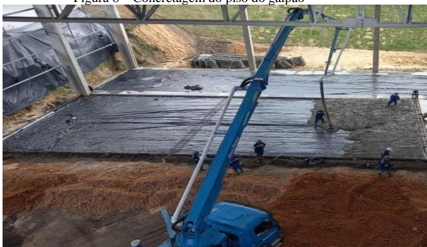
Figura 8 – Concretagem do piso do galpão
