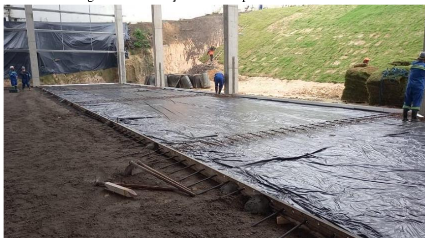
Figura 7 – Instalação do filme polietileno na área
