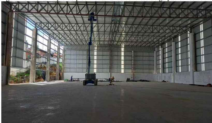
Figura 10 – Finalização do piso industrial de concreto do galpão em estudo
