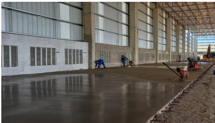
Figura 9 – Acabamento superficial do piso do galpão
