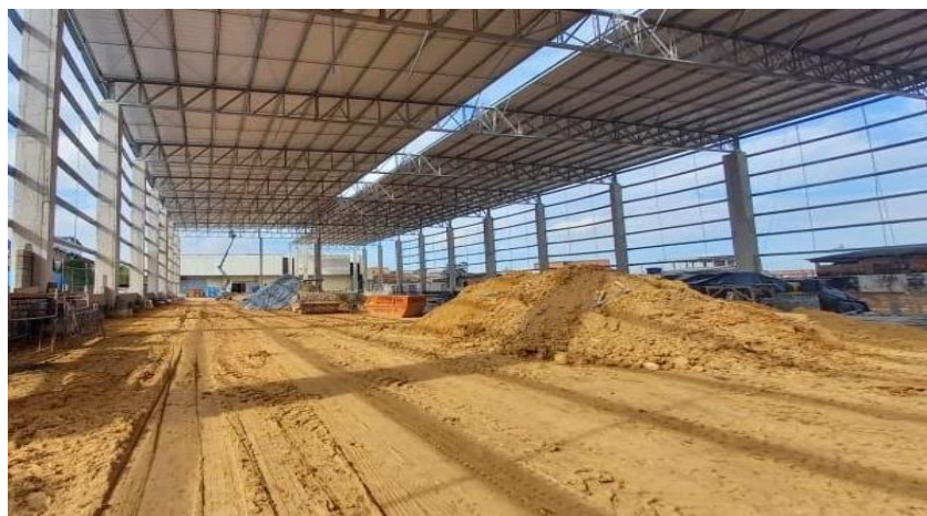
Figura 6 – Compactação da sub-base do terreno
