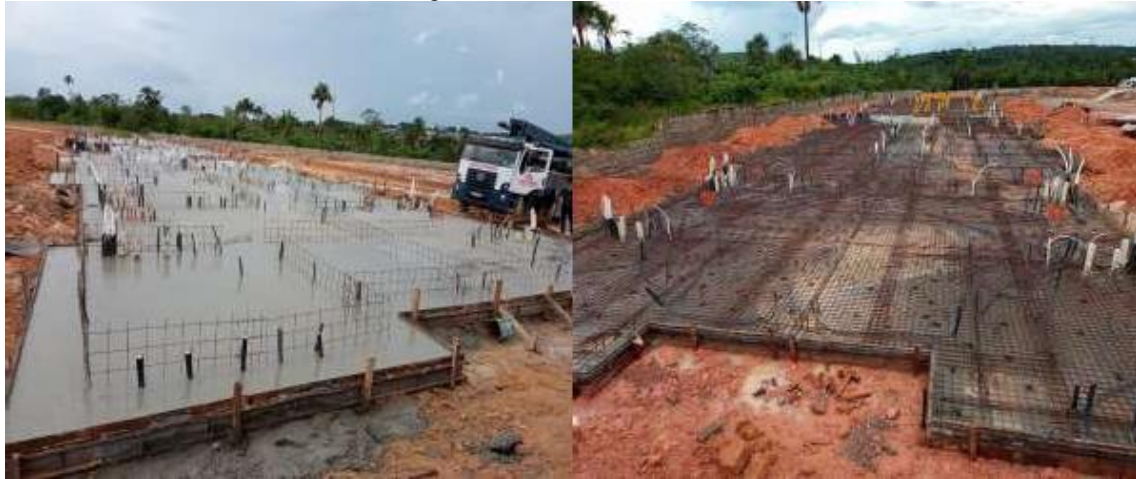
Figura 4 - Radier de Concreto
