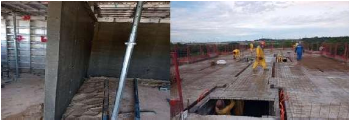
Figura 7 – Estruturas montadas com os revestimentos com fôrma de alumínio conforme A e B sem a forma de alumínio
