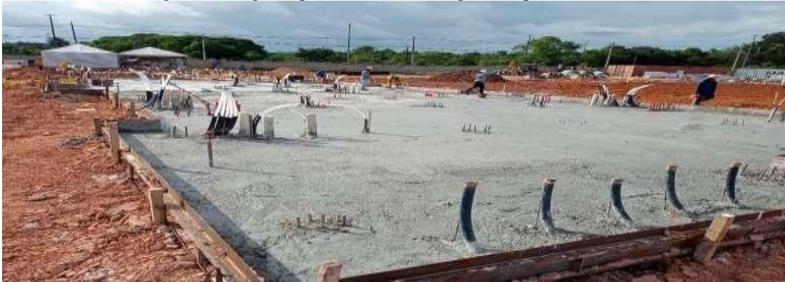
Figura 2 – Magro impermeabilizar com argamassa polimérica 1000
