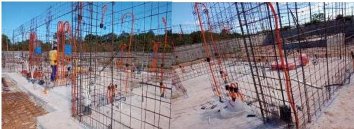
Figura 5 – Armação de parede
