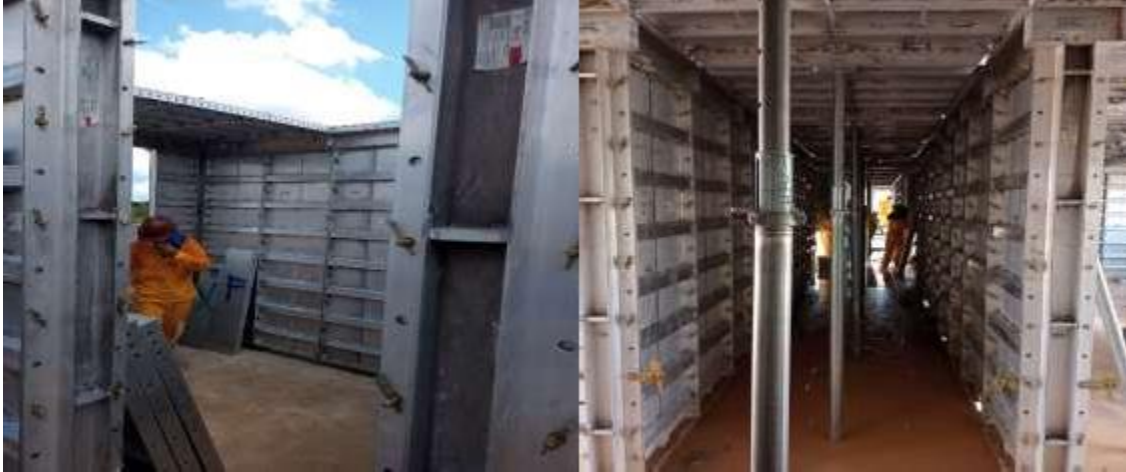
Figura 6 - Montagem da fôrma de alumínio
