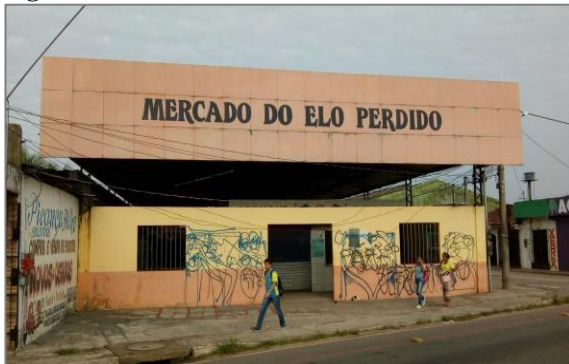
Figura 9. Fachada do Mercado Elo Perdido.
