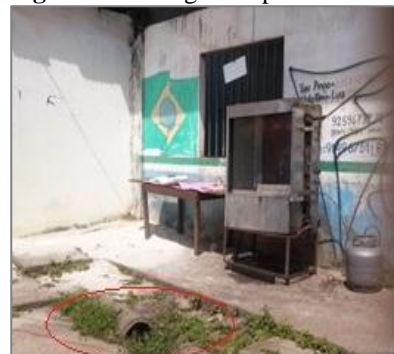
Figura 6. Drenagem exposta.
