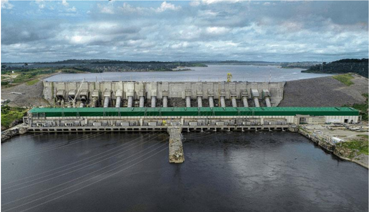
Figura 3 - Usina Hidrelétrica de Belo Monte
