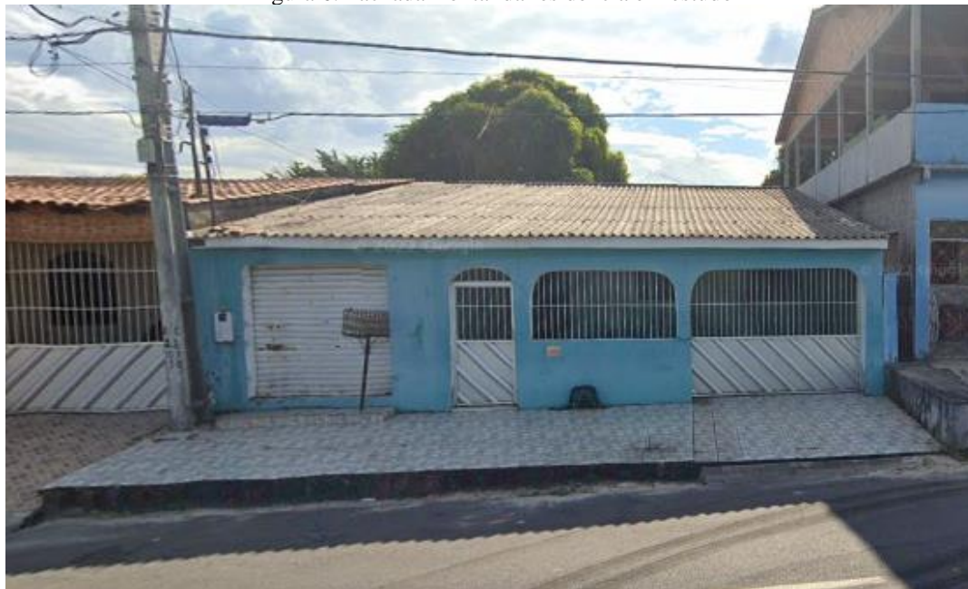
Figura 6. Fachada frontal da residência em estudo
